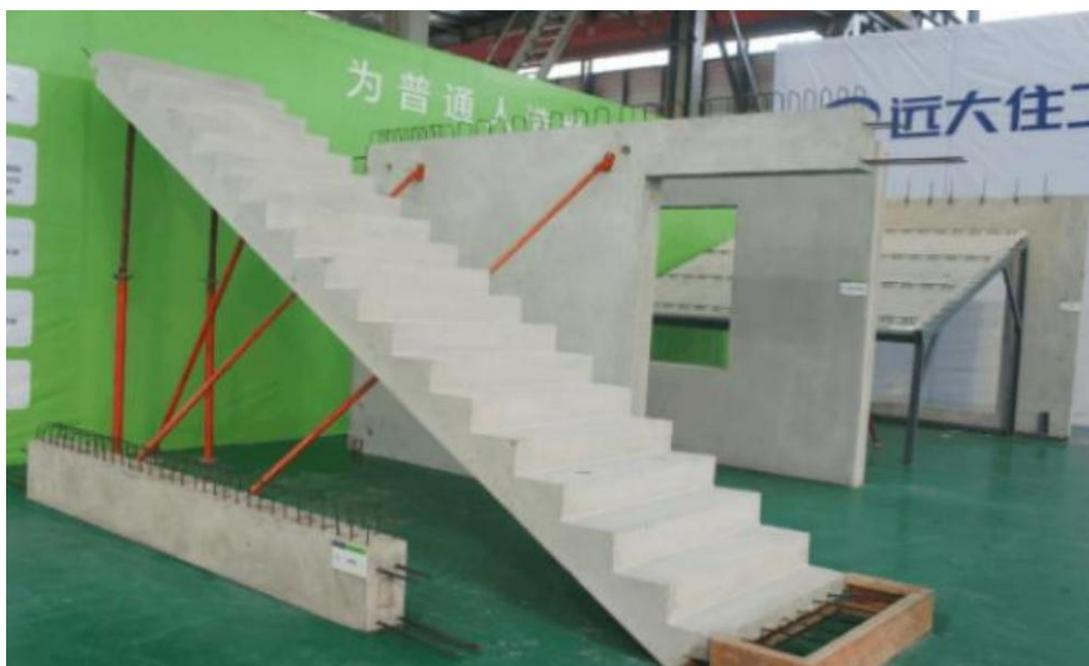
预制楼梯的优点：预制楼梯工业化生产的烙印非常明显，机械化施工程度更高，预制楼梯在工厂整体为清水混凝土浇筑，外表肌理异常细密，无需再做装饰面。安装也很便捷，减少了现场施工量，真正达到品质坚固，安装便捷，外表美观。
